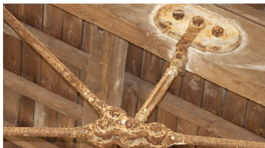
Détail de la charpente Polonceau, 2011. Photo Benjamin Sellier.
